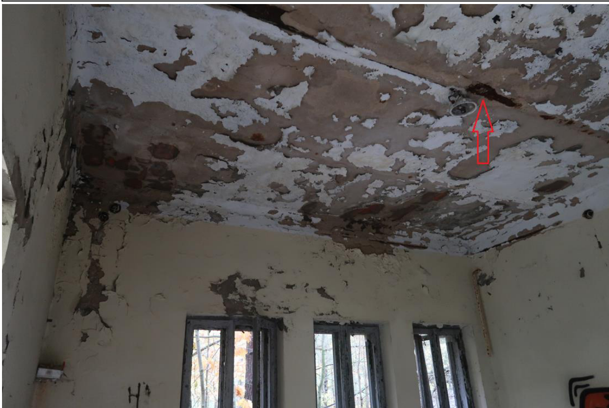
Fot. 30. Zaciekach na suficie i na ścianach. Widoczne odparzenie powłoki malarskiej oraz tynku, a także korozja powierzchniowa belki stropowej.
