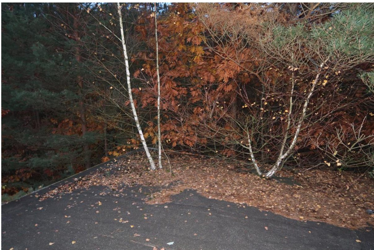
Fot. 33. Porastająca roślinność na stropodachu.
