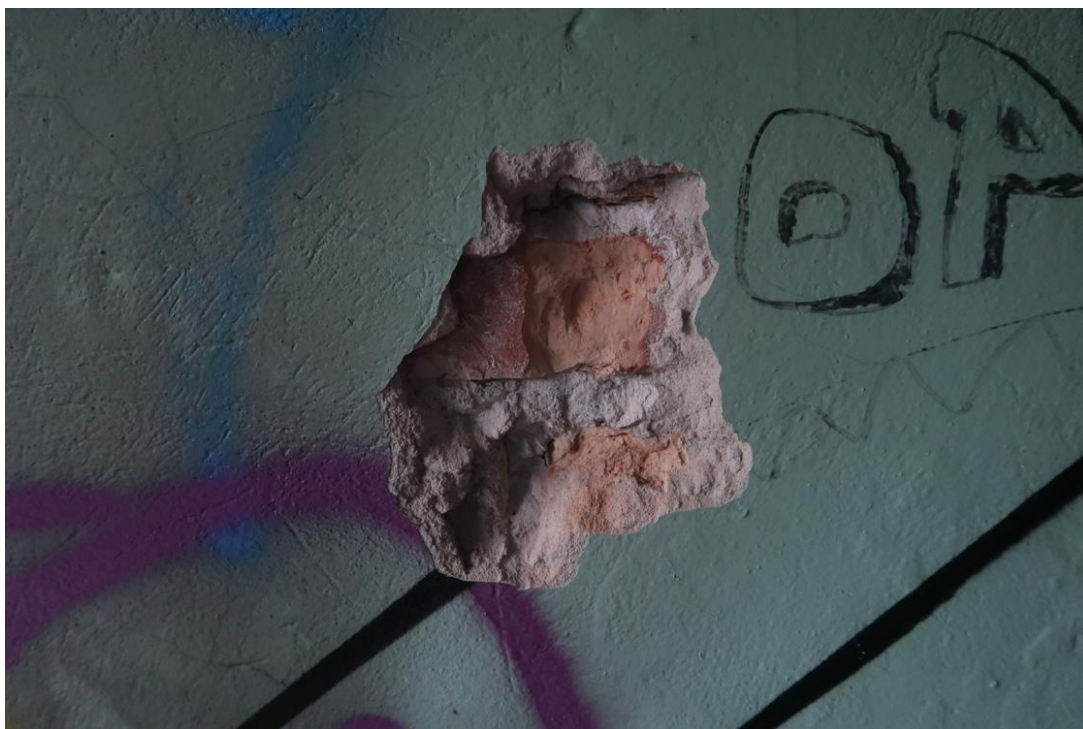
Fot. 9. Odkrywka O.4 ściany wewnętrznej. Stwierdzono konstrukcję ściany z cegły ceramicznej pełnej murowanej na zaprawie cementowo-wapiennej. Tynk c-w gr. 2,0cm.
