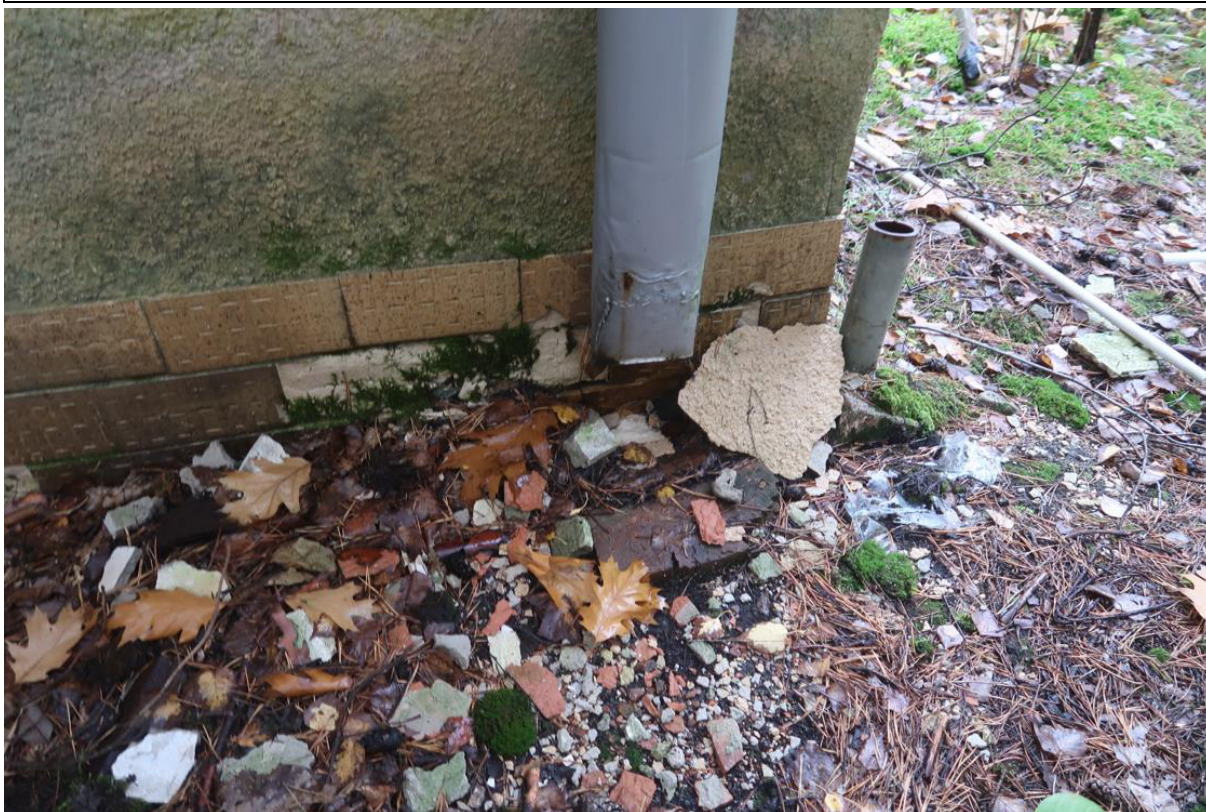
Fot. 42. Brak wylewki systemu odprowadzania wody opadowej.
