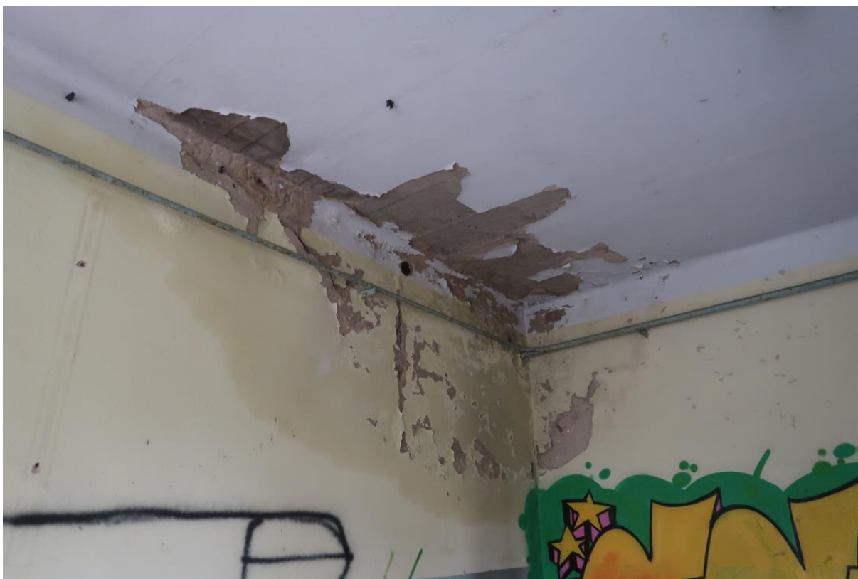
Fot. 29. Zacieki na suficie i na ścianach. Widoczne odparzenie powłoki malarskiej.
