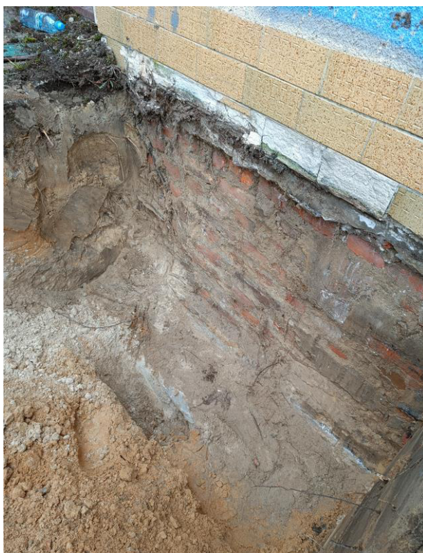
Fot. 6. Odkrywka F.1. fundamentów. W wykonanej odkrywce stwierdzono ścianę fundamentową ceglana posadowioną na gruzobetonowej ławie gr. 30cm z odsadzką 36cm. Ława jest posadowiona około 120cm p.p.t.
