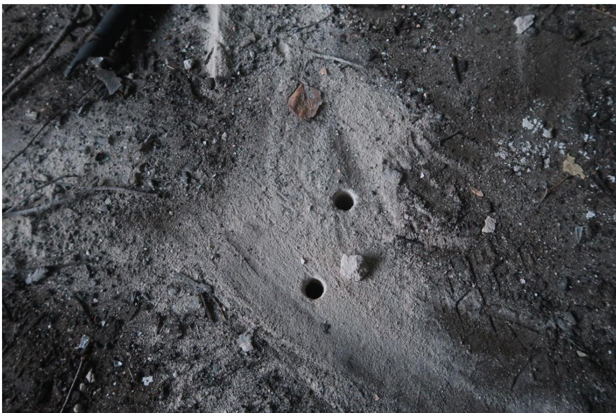
Fot. 36. Odkrywka O.3 posadzki. Stwierdzono płytę betonową gr. 15-18cm, o zróżnicowanej wytrzymałości.
