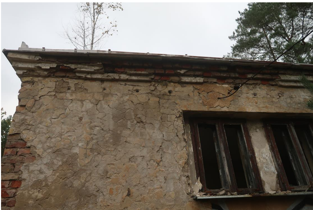
Fot. 16. Fragment elewacji południowej budynku. Widoczny odparzony tynk oraz erozja gzymsu.
