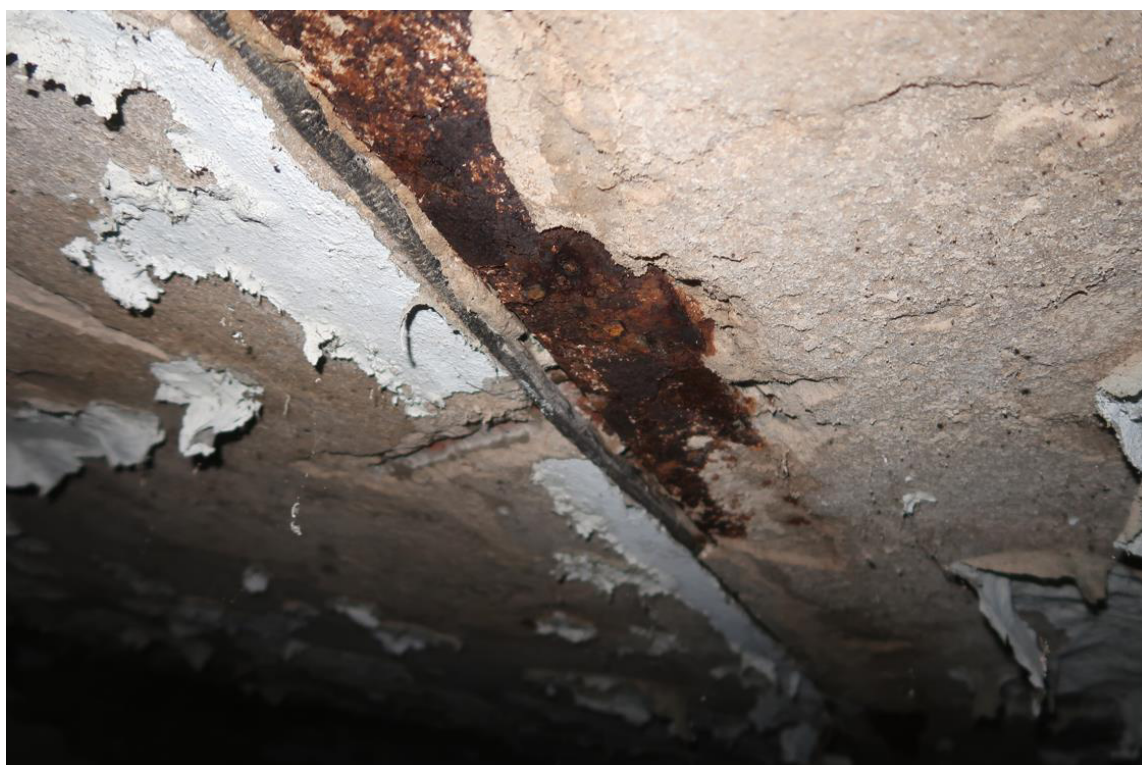
Fot. 25. Odkrywka O.7 stropu Kleina. Stwierdzono płyty ceglane półciężkie wykonane z ceramicznej cegły dziurawki, zbrojone w spoinach żeber prętami gładkimi \varnothing 6 . Tynk c-w gr. 1,0cm. Płyty ceglane oparte na dolnych półkach belek stalowych wykonanych z dwuteowników IPN160, skorodowanych powierzchniowo i lokalnie płatowo. Belki w rozstawie co ok. 105cm. Cegły płyty stropowej nie są zerodowane.
