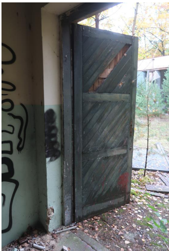
Fot. 39. Uszkodzone i zużyte drewniane drzwi garażowe.
