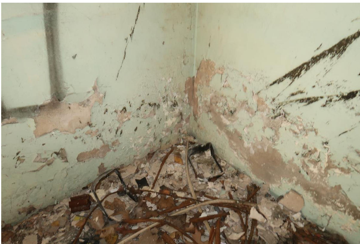
Fot. 18. Odparzona powłoka malarska i zawilgocony tynk na ścianach w dolnej partii w jednym z pomieszczeń przedmiotowego budynku.
