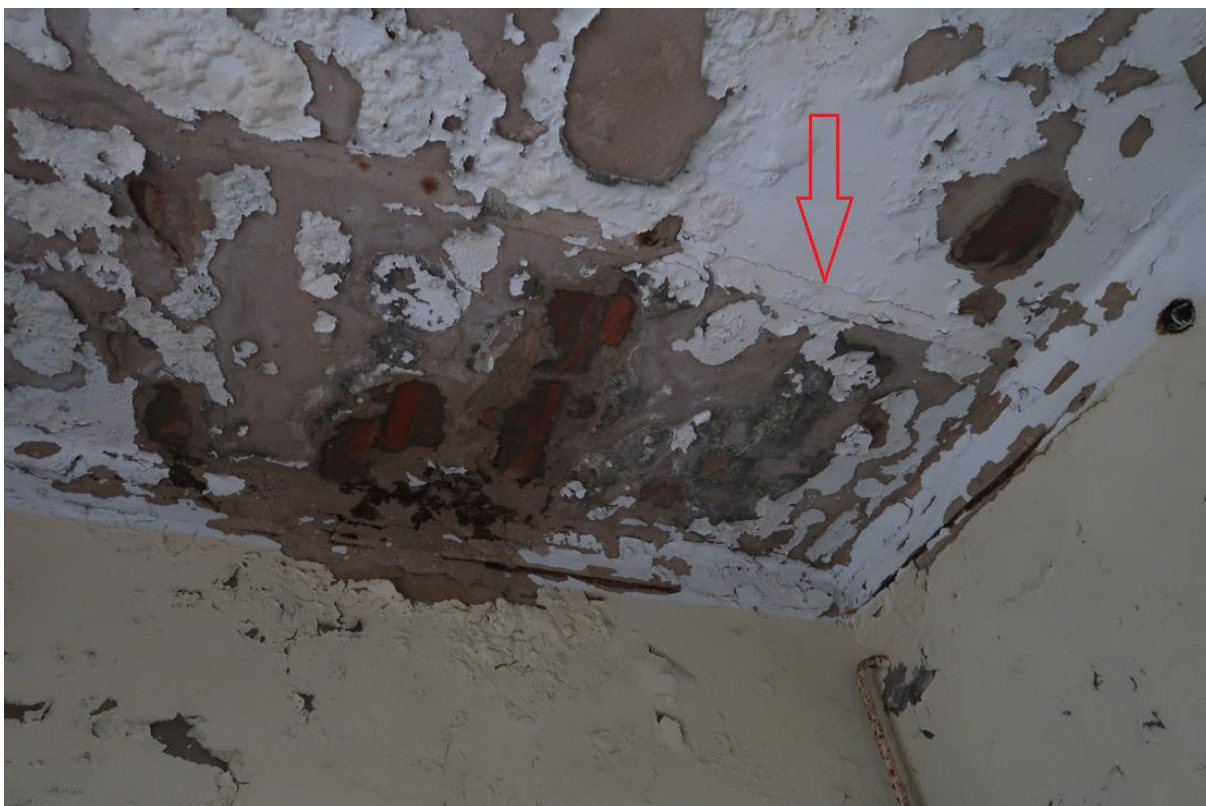
Fot. 31. Zacieki na suficie i na ścianach. Widoczne odparzenie powłoki malarskiej oraz tynku, a także zarysowanie na suficie w miejscu występowania belki stropowej.
