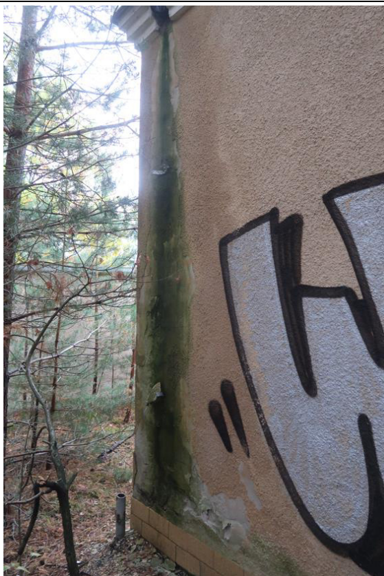
Fot. 15. Fragment elewacji wschodniej budynku. Widoczny odparzony tynk oraz zagłobienie w miejscu brakującej rury spustowej.
