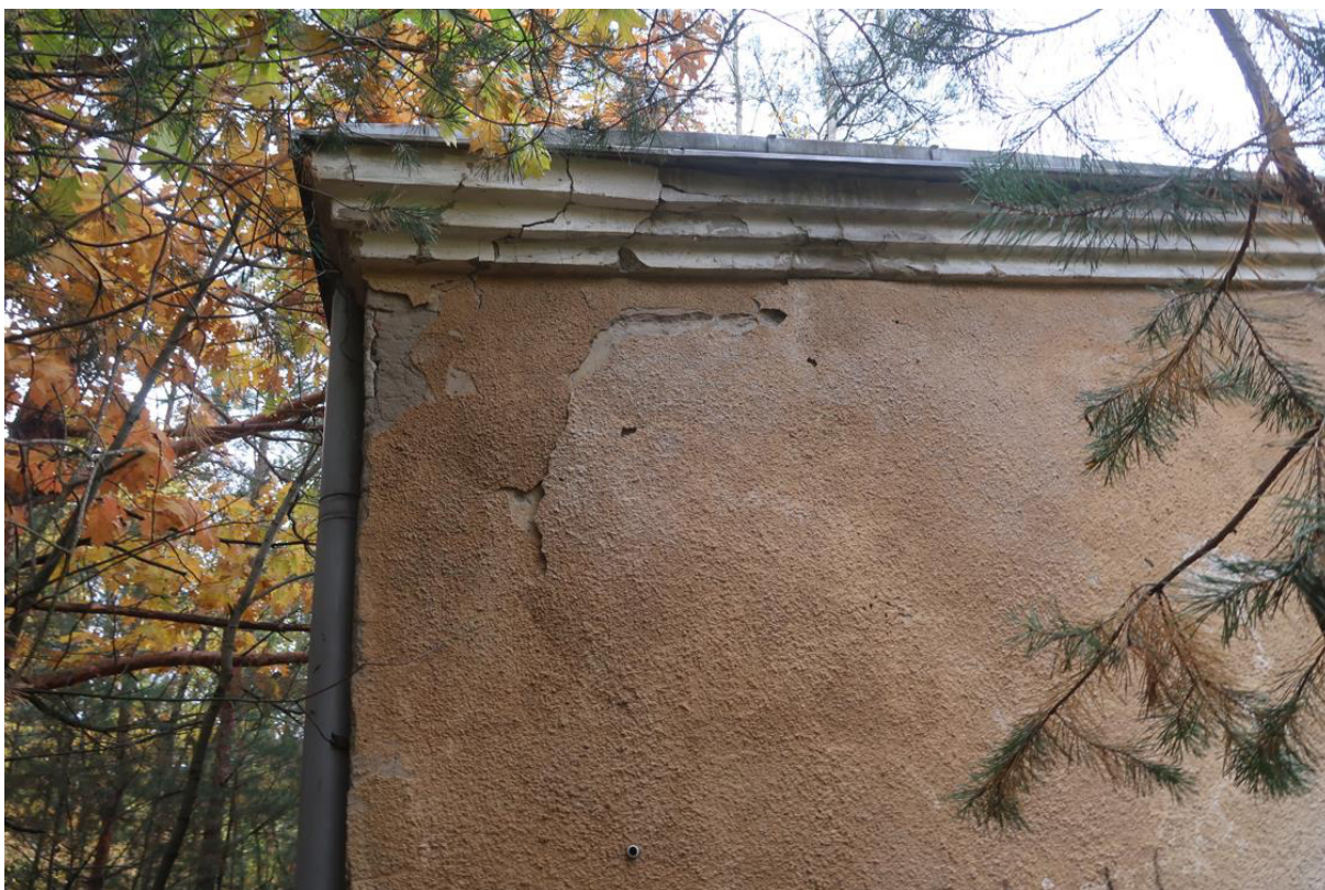
Fot. 12. Fragment elewacji północnej budynku. Widoczny odparzony tynk na elewacji oraz zarysowanie gzymsu.
