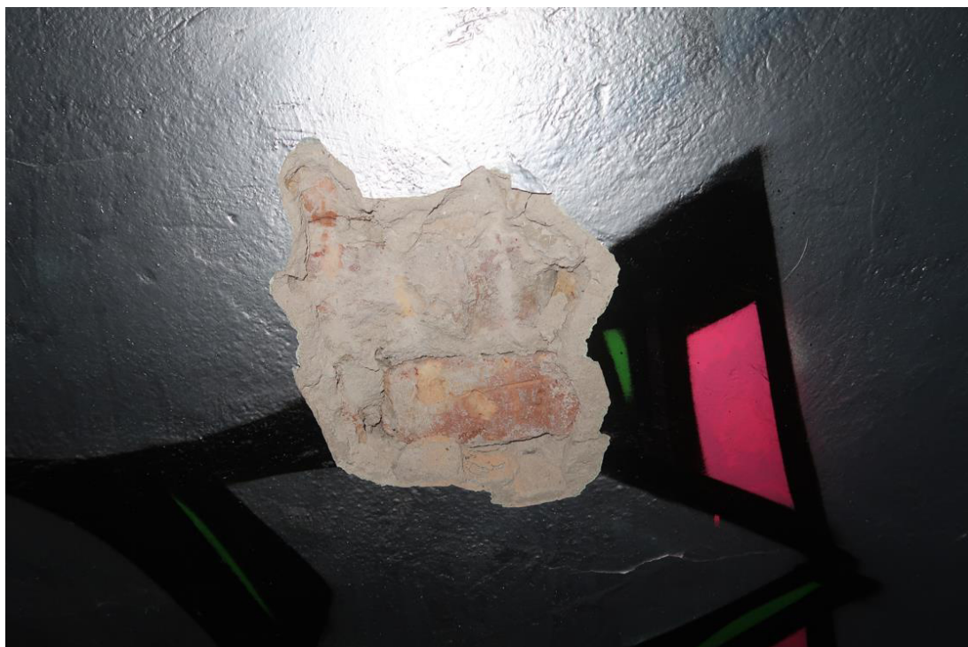
Fot. 10. Odkrywka O.5 ściany zewnętrznej. Stwierdzono konstrukcję ściany z cegły ceramicznej pełnej murowanej na zaprawie cementowo-wapiennej. Tynk c-w gr. 2,0cm.
