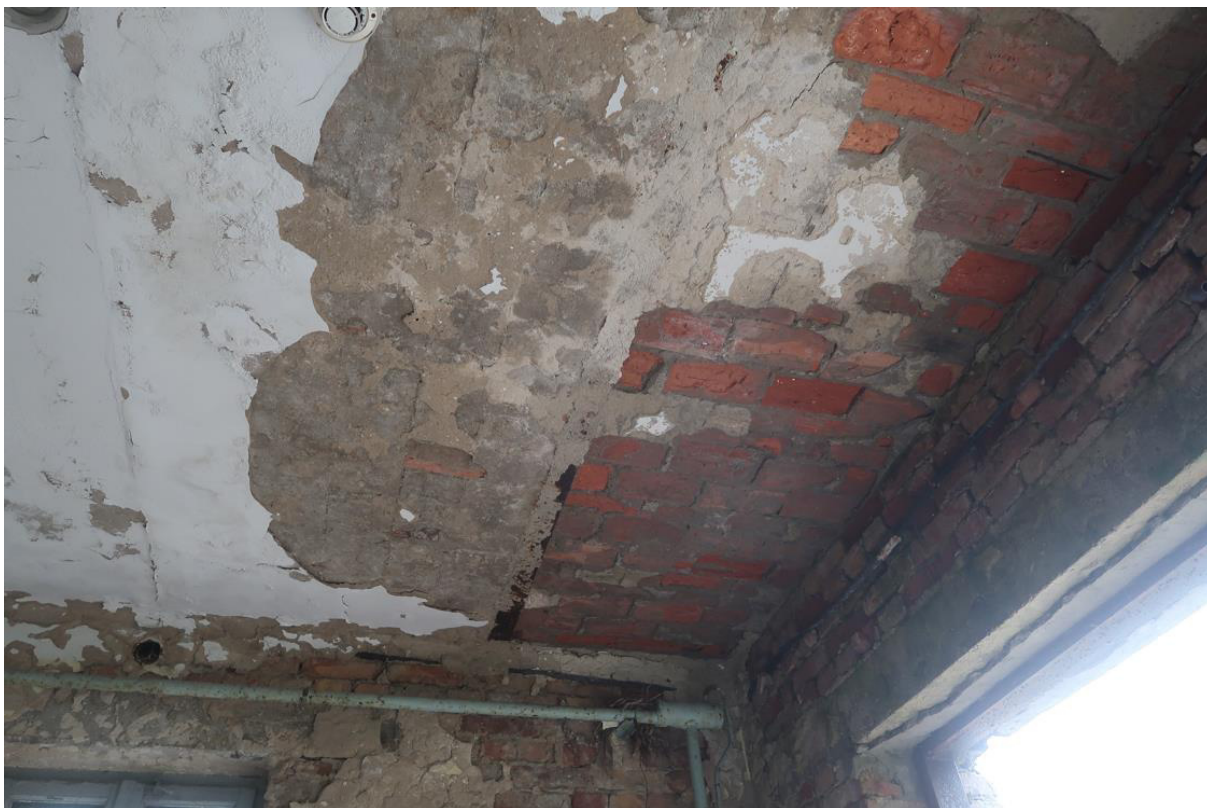
Fot. 27. Odparzony tynk na suficie. Widoczna płyta stropu Kleina oraz belka stalowa, powierzchniowo skorodowana.
