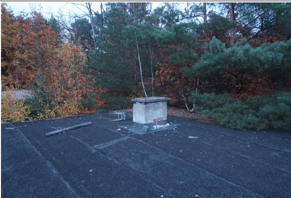
Fot. 32. Wierzch stropodachu pokryty papą. Widoczne zalegające śmieci oraz fragmenty tynku i cegły z zerodowanego komina.
