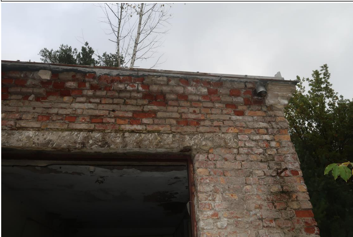
Fot. 11. Fragment elewacji zachodniej budynku. Widoczny brak tynku na elewacji, erozja cegły i zaprawy oraz brak rury spustowej.
