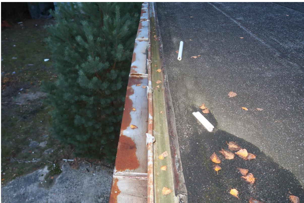
Fot. 43. Korozja obróbki blacharskiej gzymsu.
