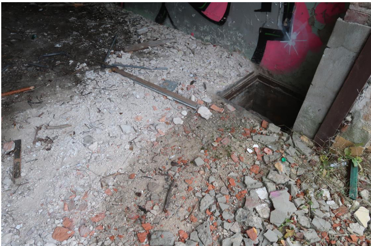
Fot. 38. Zagruzowana posadzka betonowa i widoczny kanał w narożu ścian.
