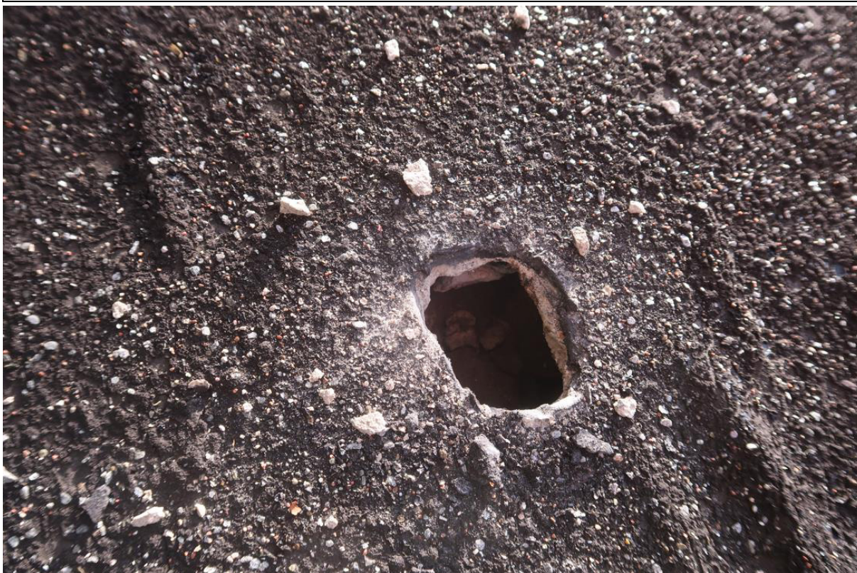
Fot. 26. Odkrywka 0.9 wierzchnich warstw stropodachu. Stwierdzono pokrycie z papy wykonane na wylewce cementowej gr. 3÷4cm. Pod wylewką stwierdzono występowanie warstwy spadkowej z polepy gruzowej o gr. ~27cm w miejscu odkrywki.
