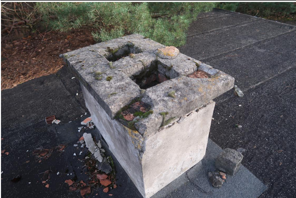
Fot. 41. Erozja czapy kominowej. Widoczne ubytki tynku z komina leżące na pokryciu dachowym.
