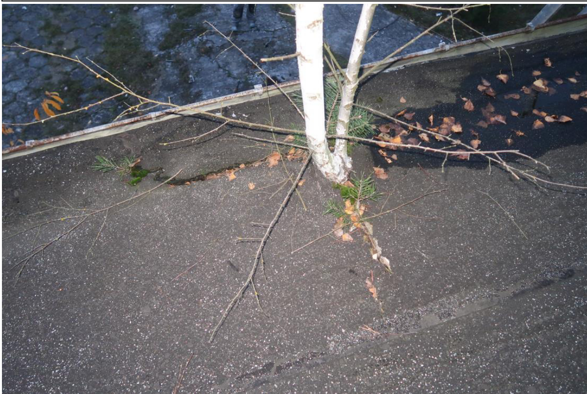
Fot. 34. Porastająca roślinność na stropodachu i popękane porycie z papy.
