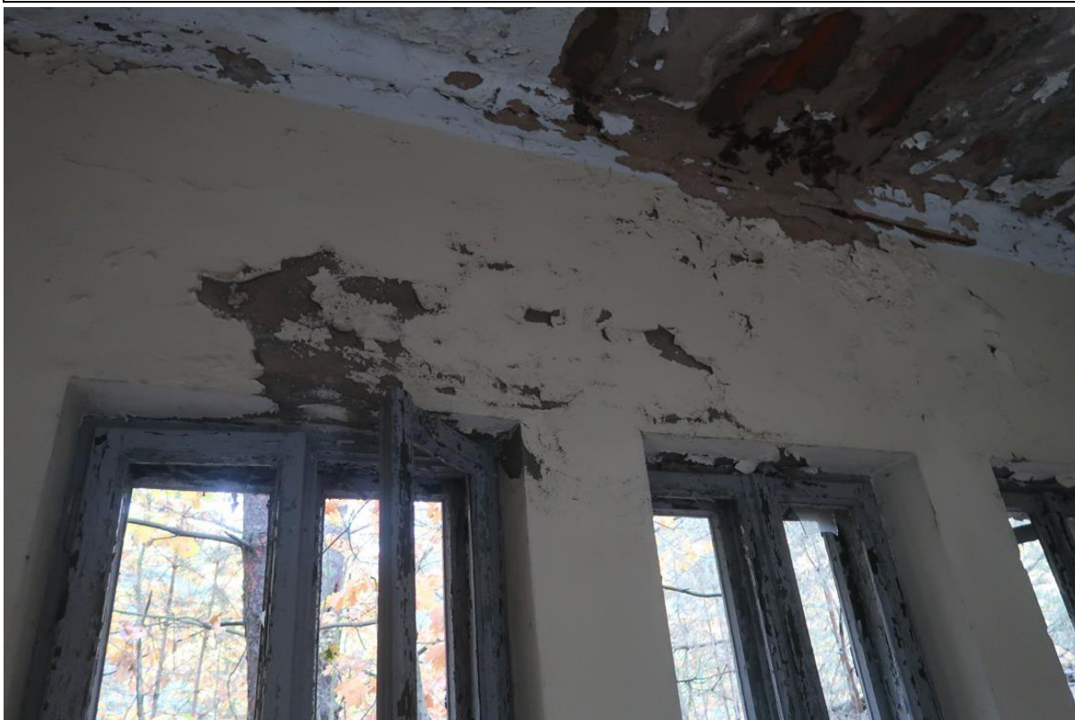
Fot. 19. Odparzona powłoka malarska i zawilgocony tynk na ścianach nad rzędem okien w jednym z pomieszczeń przedmiotowego budynku.
