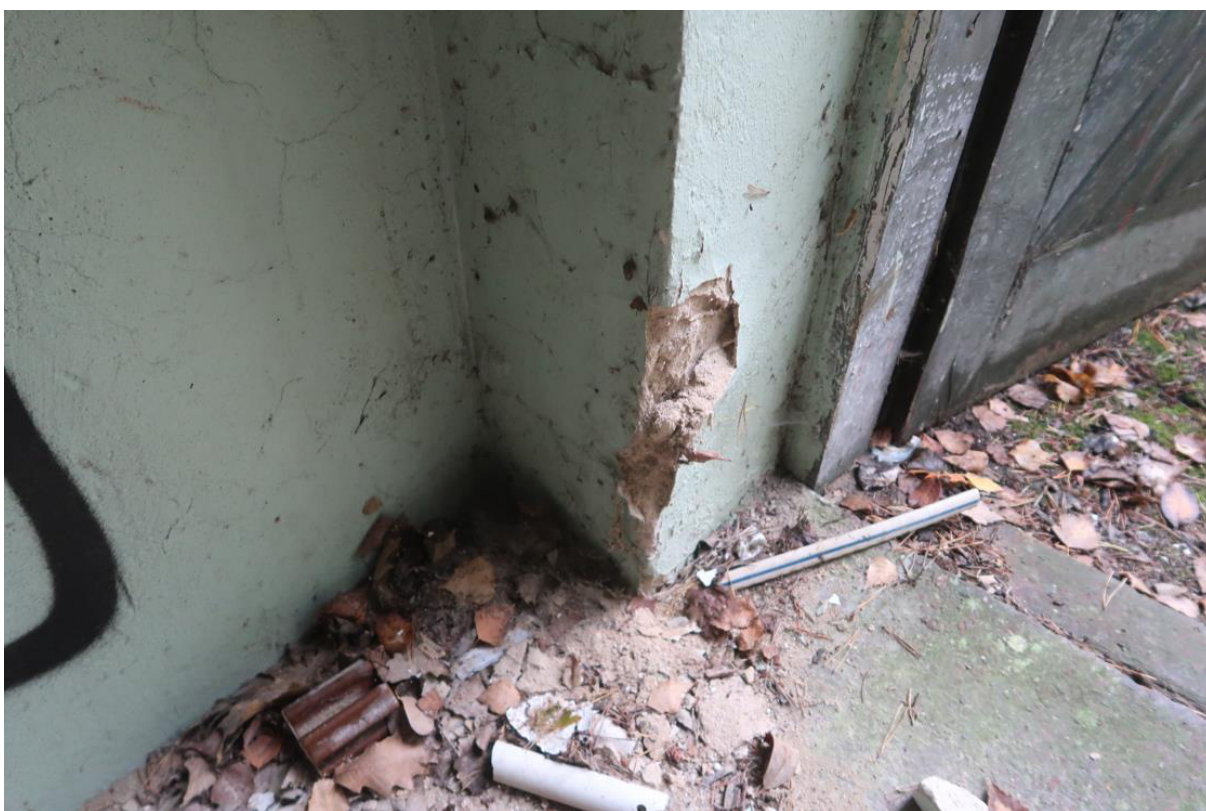
Fot. 20. Ubytek tynku na glifie przy wejściu do jednego z pomieszczeń przedmiotowego budynku.
