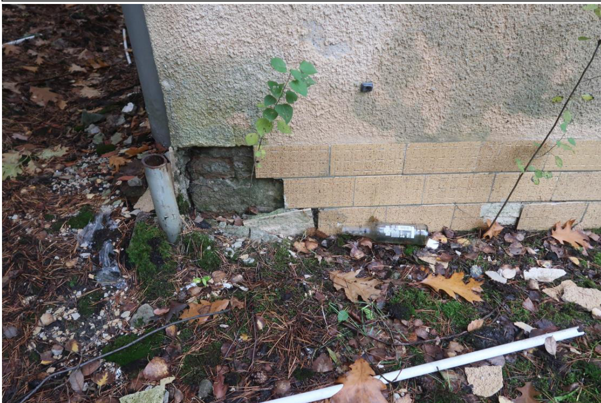
Fot. 13. Fragment elewacji północnej budynku. Widoczne odparzone płytki cokołu.
