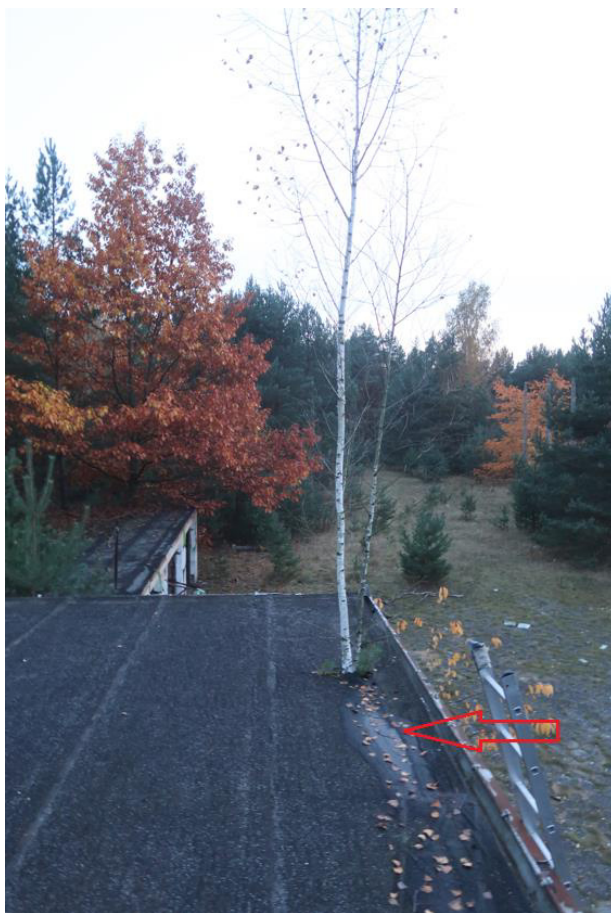
Fot. 35. Porastająca roślinność i zalegająca woda opadowa na stropodachu.
