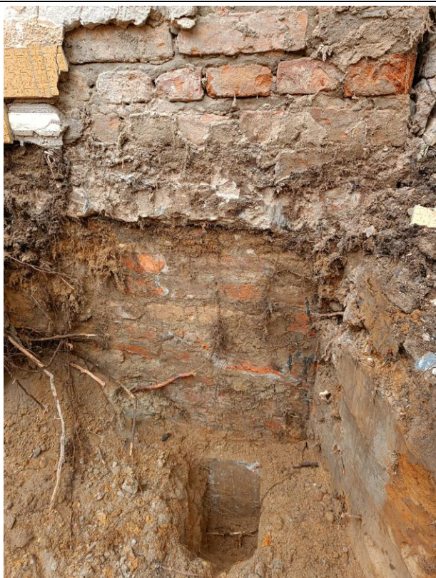
Fot. 7. Odkrywka F.2. fundamentów. W wykonanej odkrywce stwierdzono ścianę fundamentową ceglana posadowioną na gruzobetonowej ławie gr. 44cm z odsadzką 6cm. Ława jest posadowiona około 134cm p.p.t.
