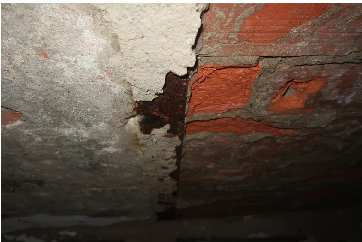
Fot. 23. Odkrywka O.1 stropu Kleina. Stwierdzono płyty ceglane półciężkie wykonane z ceramicznej cegły dziurawki, zbrojone w spoinach żeber prętami gładkimi \varnothing 6 . Tynk c-w gr. 1,0cm. Płyty ceglane oparte na dolnych półkach belek stalowych wykonanych z dwuteowników IPN160, skorodowanych powierzchniowo. Belki w rozstawie co ok. 110cm. Cegły płyty stropowej nie są zerodowane.
