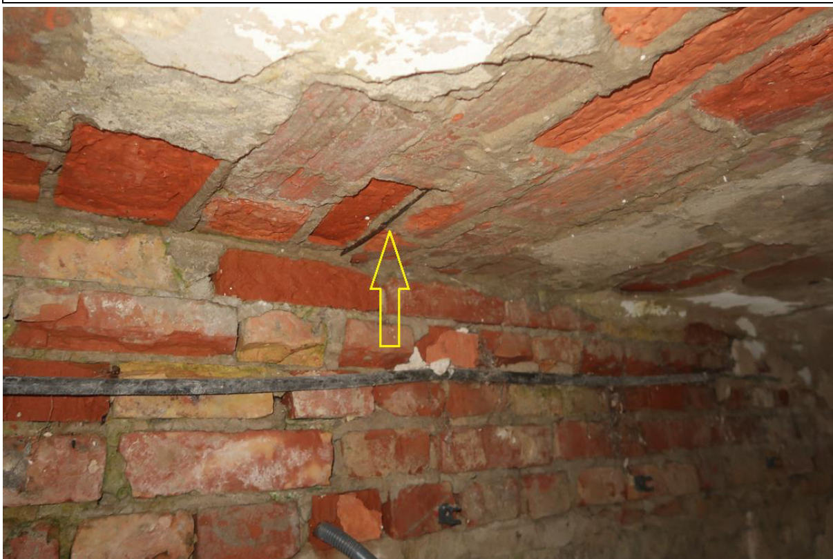
Fot. 28. Odparzony tynk na suficie. Widoczna lokalna erozja cegieł w płycie stropu Kleina i powierzchniowo skorodowany pręt zbrojeniowy płyty.
