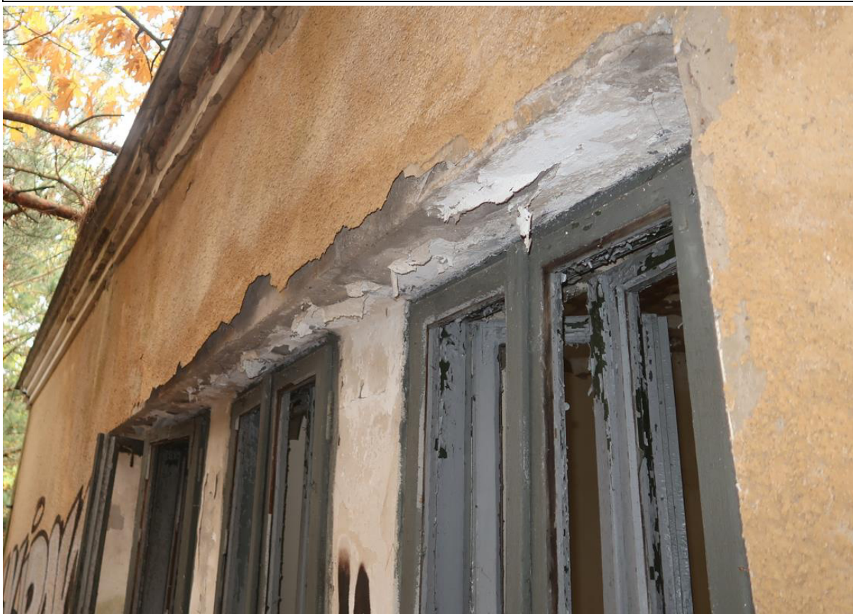
Fot. 22. Zacieki i odparzona powłoka malarska / tynk na spodzie nadproża.
