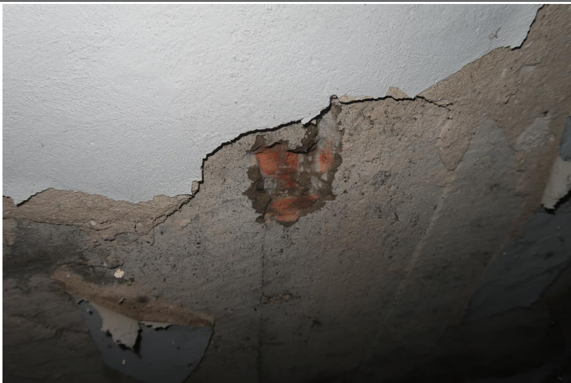
Fot. 24. Odkrywka O.2 stropu Kleina. Stwierdzono płyty ceglane półciężkie wykonane z ceramicznej cegły dziurawki. Tynk c-w gr. 1,0cm. Płyty ceglane oparte na dolnych półkach belek stalowych. Cegły płyty stropowej nie są zerodowane.
