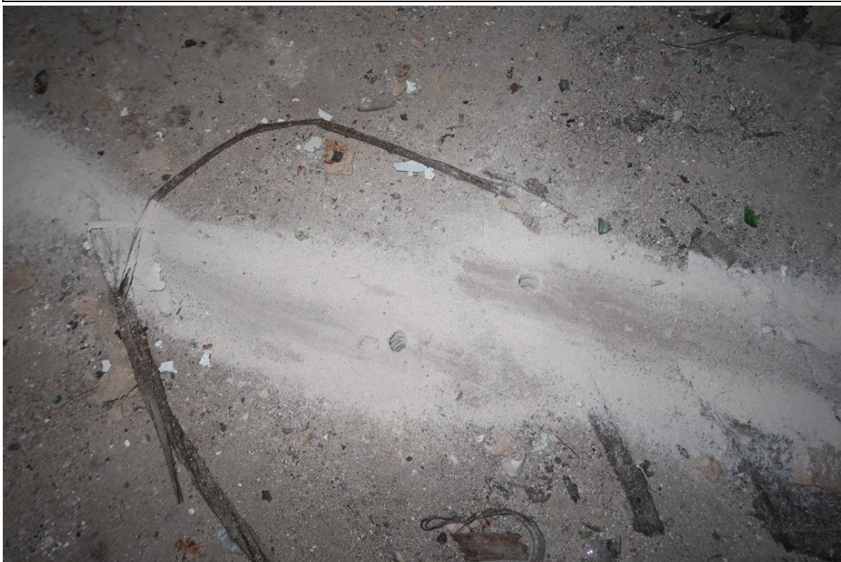
Fot. 37. Odkrywka O.8 posadzki. Stwierdzono płytę betonową gr. ~20cm.
