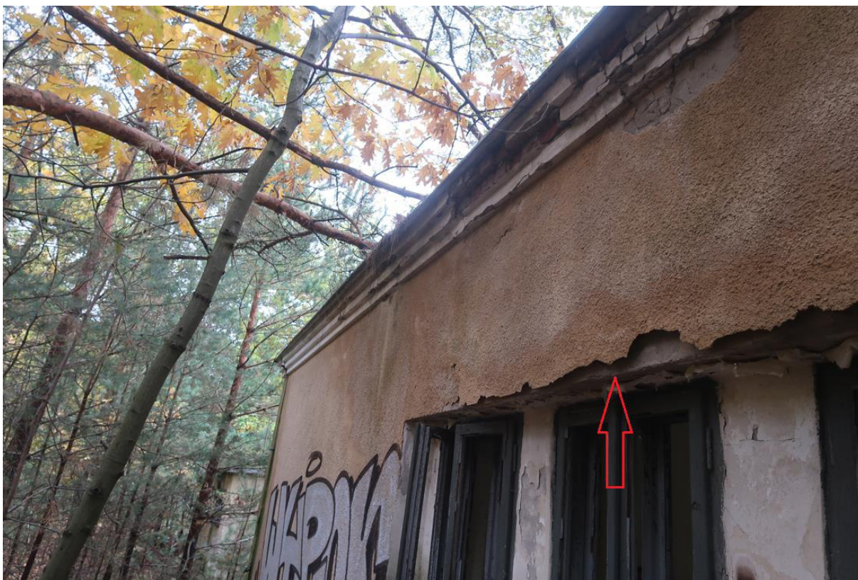
Fot. 14. Fragment elewacji wschodniej budynku. Widoczny odparzony tynk nad rzędem okien oraz erozja gzymsu.
