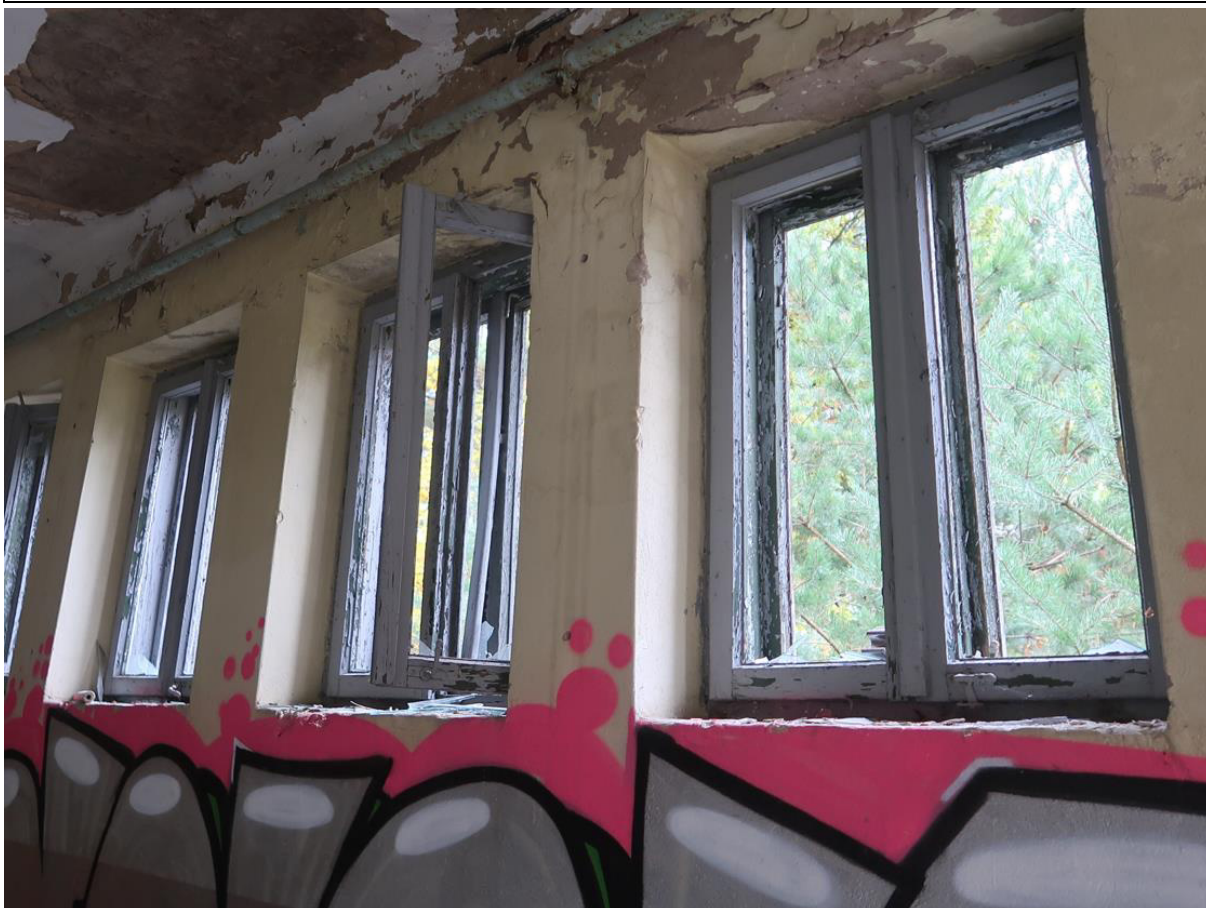
Fot. 40. Zużyta drewniana stolarka okienna typu skrzynkowego. Większość szyb jest wybitych.
