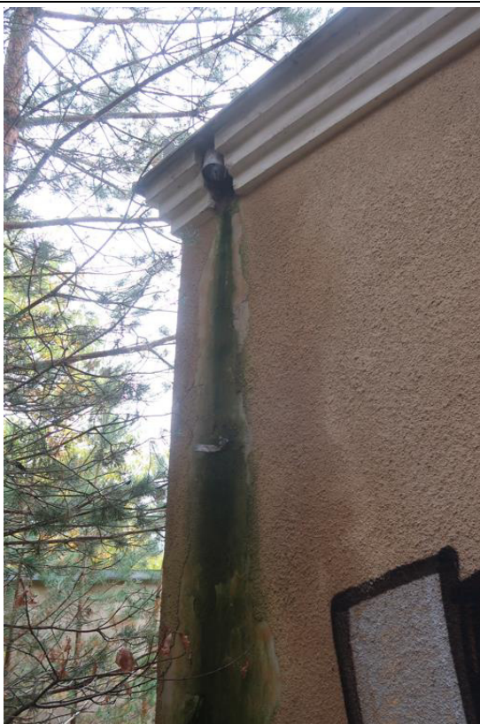
Fot. 44. Zdemontowana rura spustowa z elewacji budynku.
