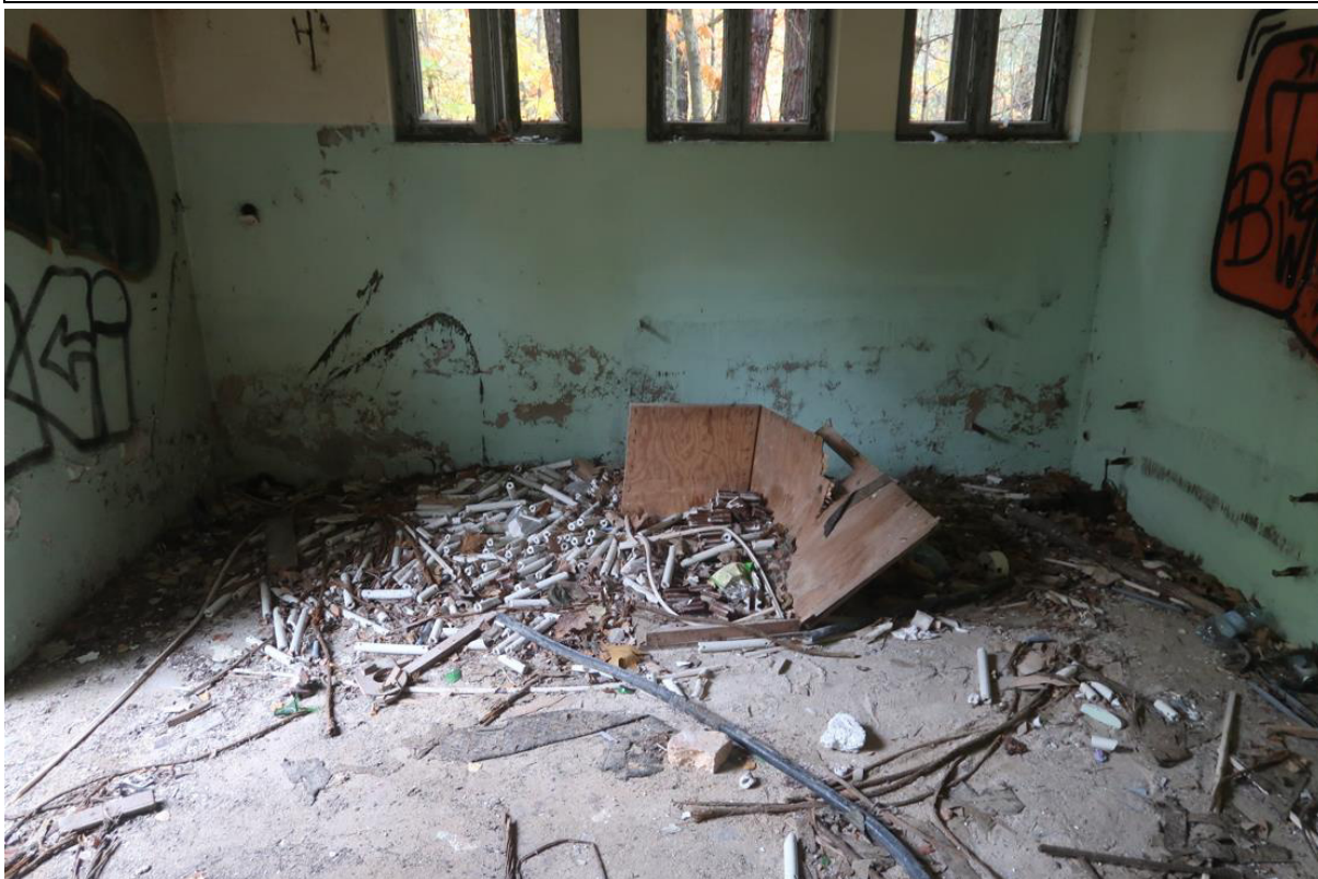
Fot. 17. Odparzona powłoka malarska / tynk na ścianach w dolnej partii w jednym z pomieszczeń przedmiotowego budynku.
